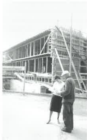
Susi Müller-Gehrigh (1926–1981), Architektin, auf einer Baustelle. Foto: Privatarchiv
